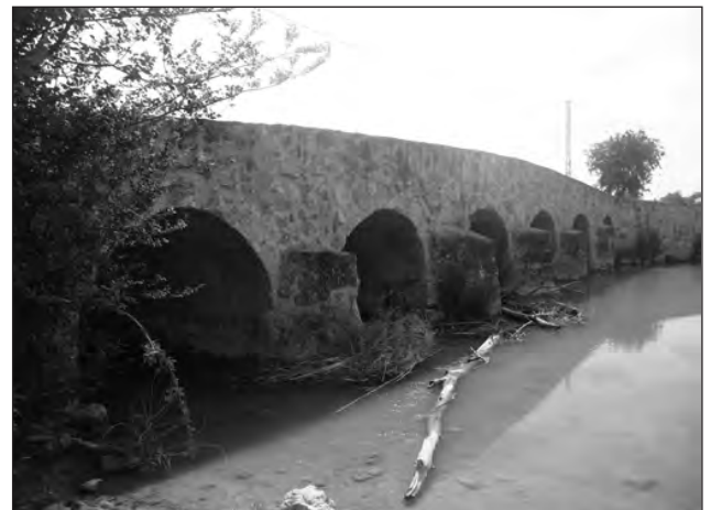
Fig. 10. Puente de Clemente.
